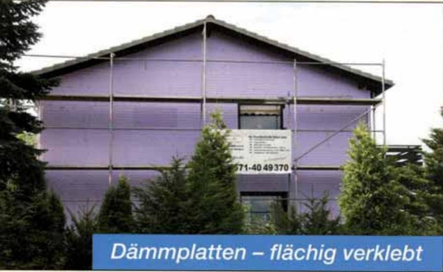
*Dämmplatten - flächig verklebt*
