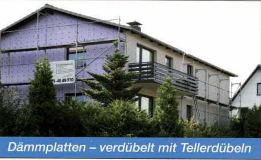
*Dämmplatten - verdübelt mit Tellerdübeln*
